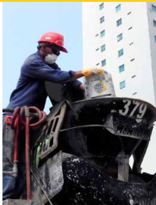
KIM在混凝土浇筑之前添加到混凝土中
