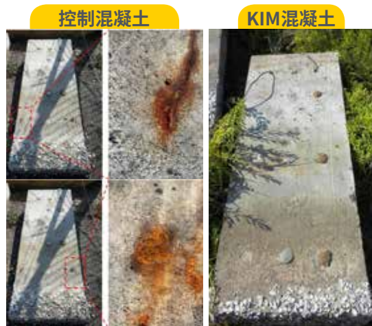
经过10年的海洋暴露之后;基准混凝土/KIM处理过的混凝土。
