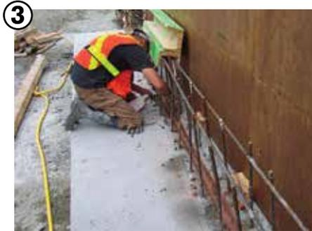
3 使用凯顿公司的施工缝止水带系统，形成物理和化学防水两道防水屏障。
