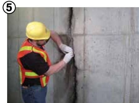
使用凯顿公司的Krystol 裂缝修补系统修补渗漏裂缝和施工缝。
