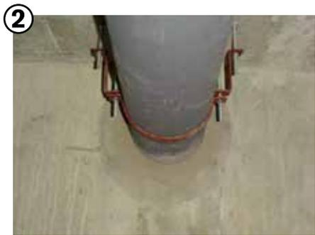
2 在穿墙管道和各种孔洞周围使用凯顿公司的混凝土止水带胶泥材料。
