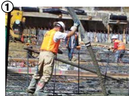
1 将凯顿公司的KIM®混凝土外加剂直接加入到预制混凝土、现浇混凝土或喷浆混凝土的墙和板中，能起到混凝土自防水的效果，完全取代了不可靠的卷材防水。
