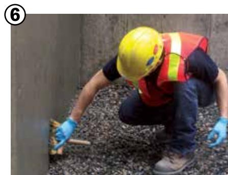
使用凯顿公司的Krystol T1& T2®表面涂刷系统能对卷材防水失败或无防水层的建筑进行防水。这种水泥浆状态的涂刷系统使用后与混凝土形成一个整体，彻底防止水的侵蚀。
