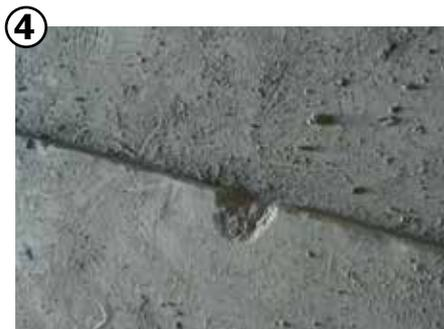
4 使用凯顿防水系统建造板与板之间的防水控制缝。
