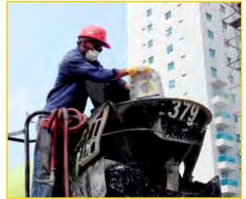
KIM用于添加到混凝土内部防水,并提高暴露在水和静水压力环境中的混凝土的耐久性:
