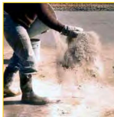
Krystol Broadcast™能形成平滑表面，并且用于整体防水，增加混凝土板的耐久性：
