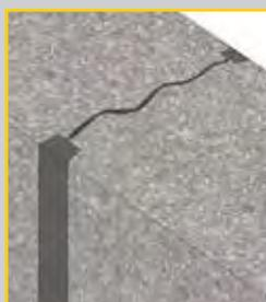
对齐的键槽可以形成一种可控的裂缝,从而通过2个外部止水带工法来引入Krystol技术,确保永久防水保护。
